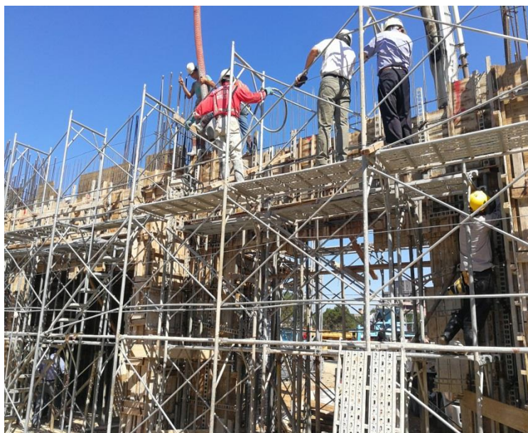
照片說明：G 棟一樓柱牆澆置
