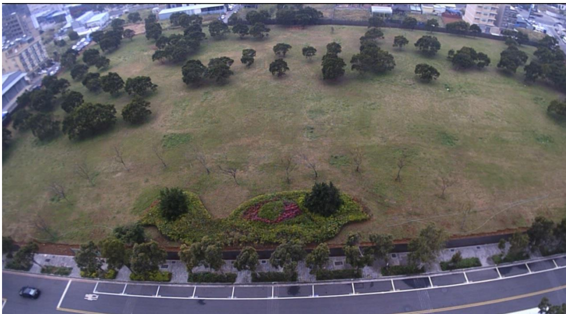
照片說明：開工前(施工前)照片-校地全景
