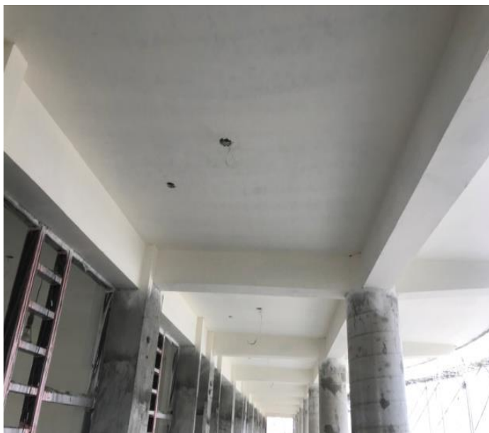
照片說明： C 棟乳膠漆打底
