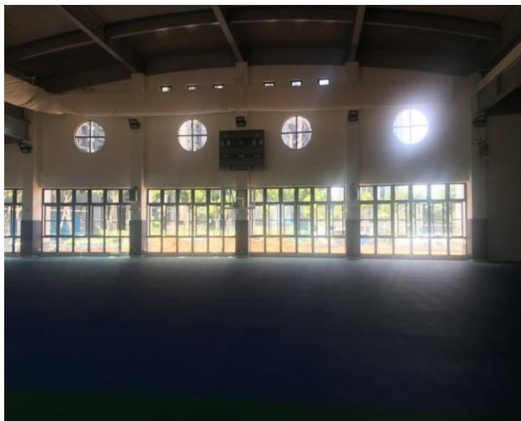
照片說明：G 棟運動設備施作
