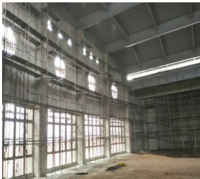
照片說明： G 棟泥作施工
