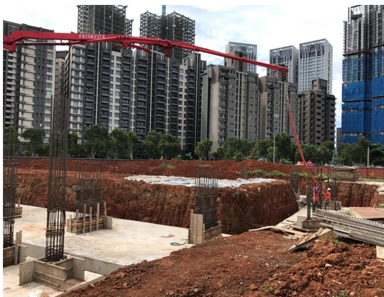
照片說明：活動中心基礎版澆灌
