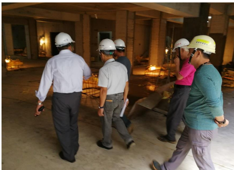
照片說明： 工務局副局長訪查-地下室泥作
