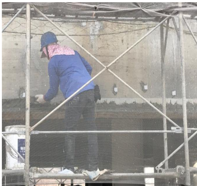
照片說明： E 棟泥作施工
