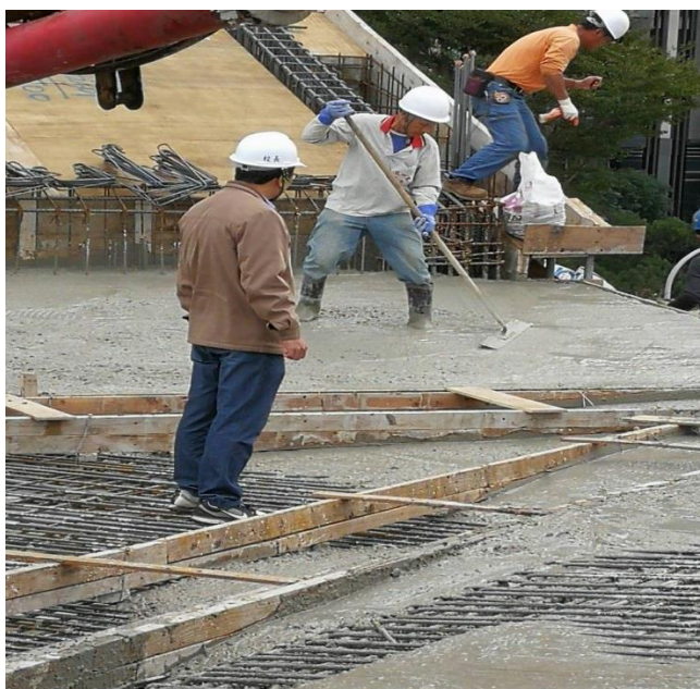
照片說明：AB棟3樓屋頂低版澆置
