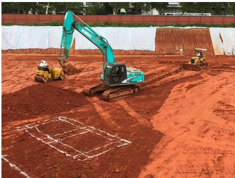
照片說明：地下室基礎夯實作業
