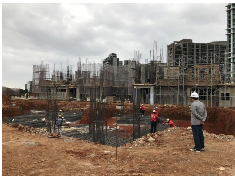
照片說明：E 棟基礎地樑鋼筋綁紮
