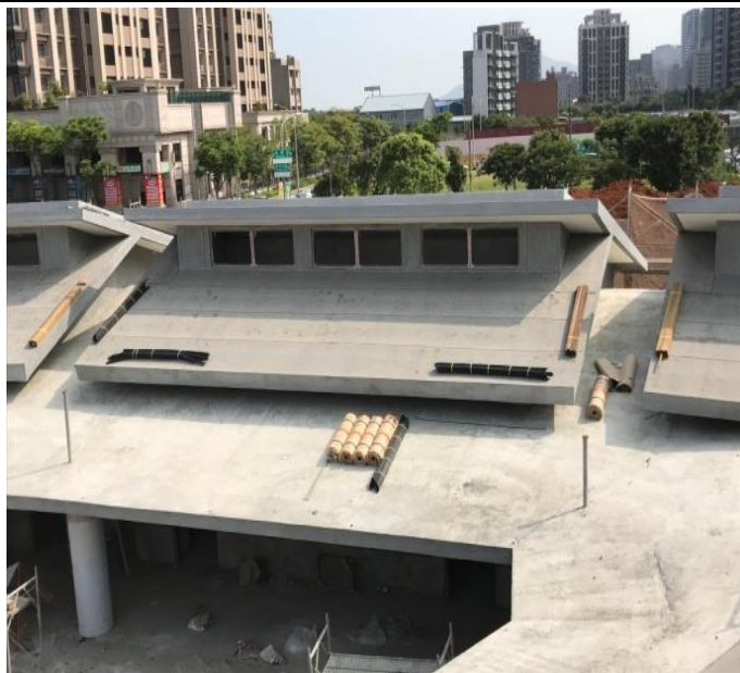
照片說明： D 棟抵石施作及文化瓦施作
