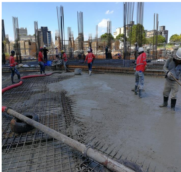
照片說明：AB 棟一樓基礎版澆灌
