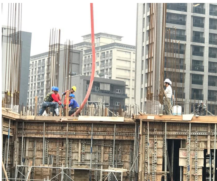
照片說明：AB 棟 2 樓版澆置
