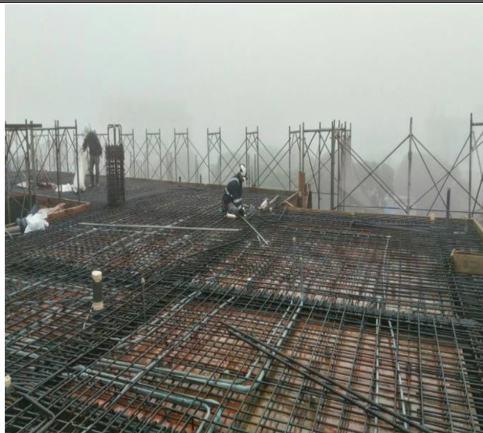
照片說明： E 棟 RFL 樑版鋼筋施工
