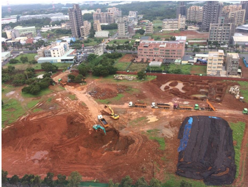
照片說明：基地動工現況
