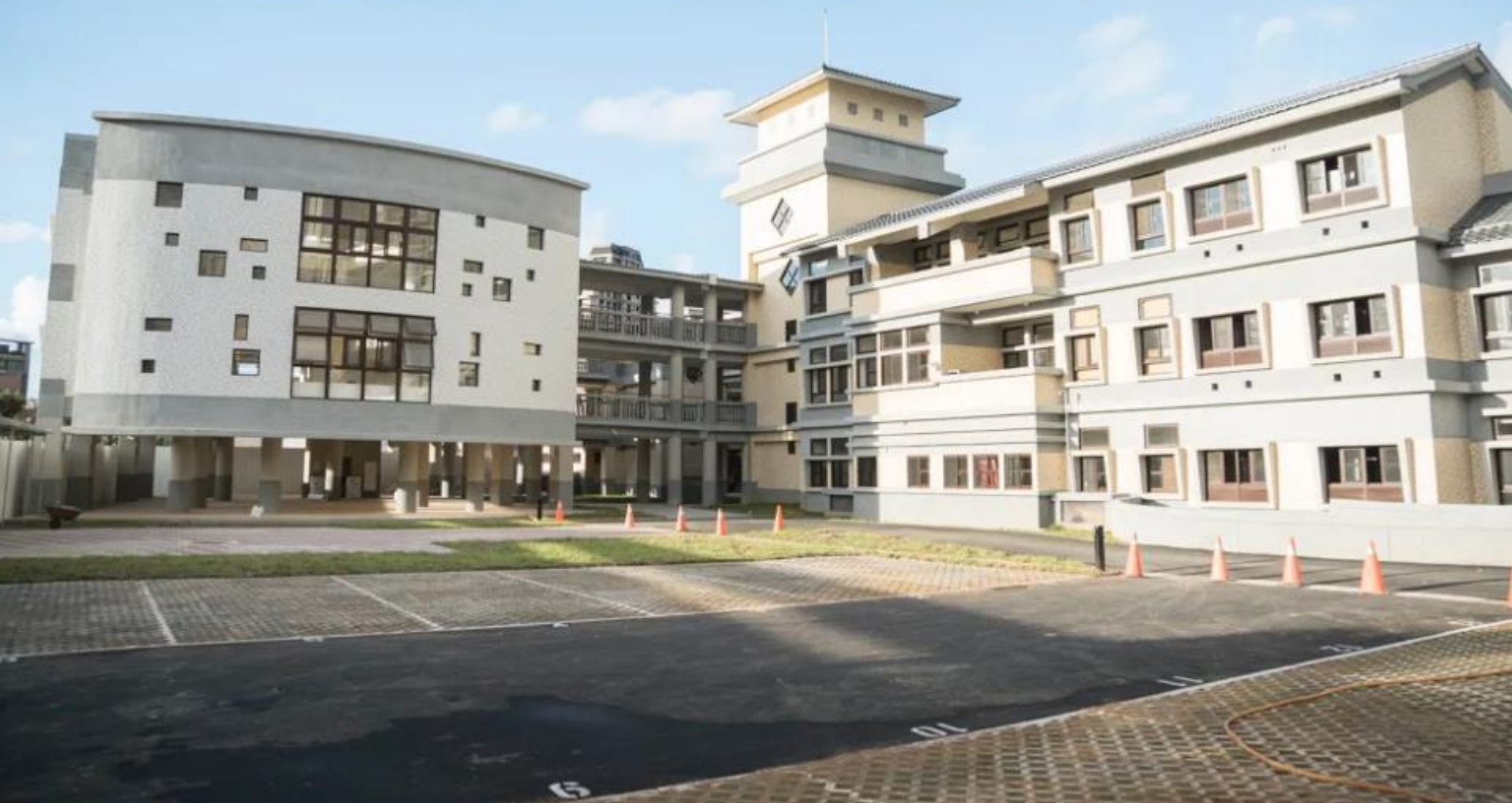
植草磚及透水鋪面(混凝土)
