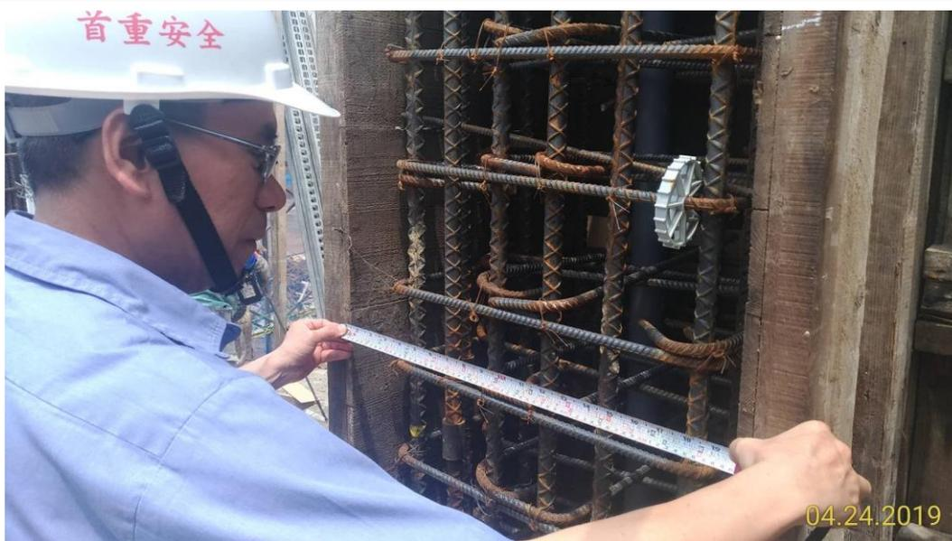
照片說明:H棟2樓柱牆鋼筋綁紮檢視
